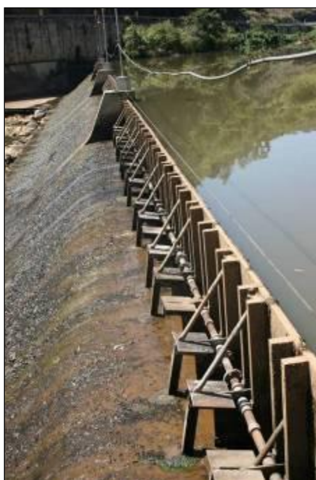
Figura 3-8. Vista do vertedouro de soleira livre e detalhe da “prancha” basculante instalada sobre a soleira de concreto.
