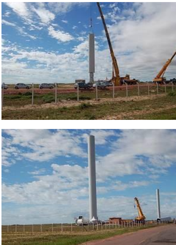
Figura 3-3. Instalação das torres do Parque Eólico de Gargaú, RJ. Fonte: http://robertoacruche.blogspot.com/2010/04/as-torres-do-parque-eolico-de-gargau.html .
