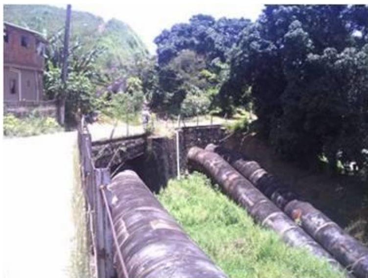
Figura 3-69. Travessia dos dutos sob a estrada
