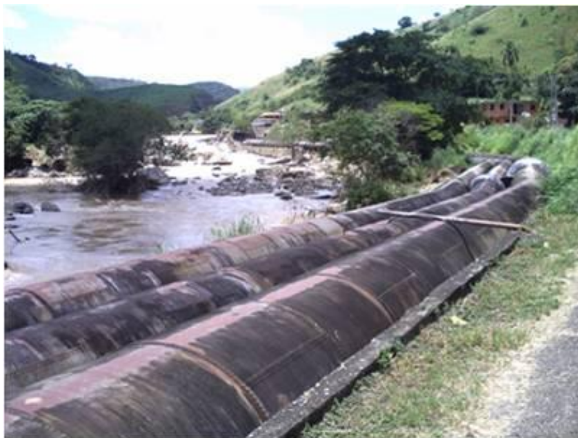
Figura 3-68. Área a jusante da barragem, detalhe da tubulação que conduz a água até a casa de força.
